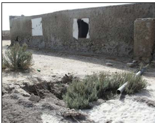
Photo 87 : Fosse septique construite sur l'estran à Cabanon «3 »
