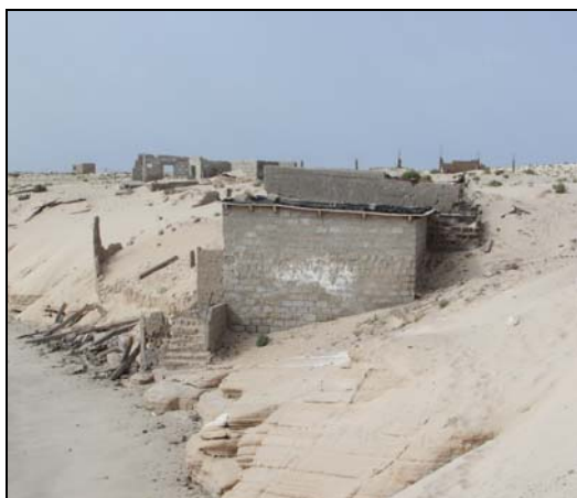
Photo 83 : Résidence secondaire en ruine à Cabanon « 1 » à Cabanon « 3 »
